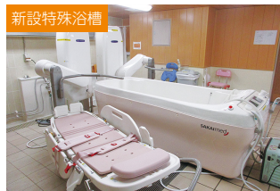
新設特殊浴槽
